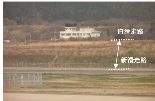
図 7 新旧滑走路間のマルチパス源(段差)
