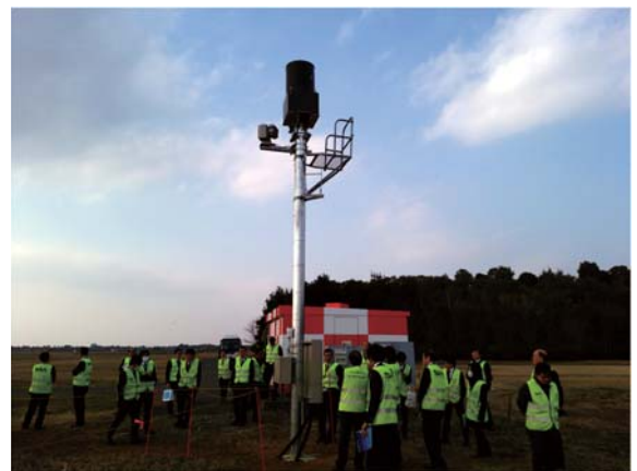
図 8 アンテナ局路面装置 A の設置状況概観
