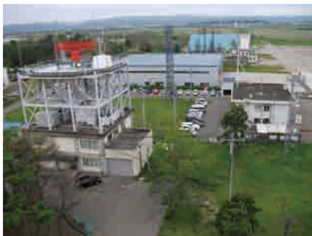
図 12 アンテナ設置位置より西の方角の建物および樹木
