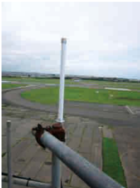
図 3 送信アンテナ設置状況
