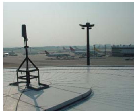
図7 構造的に高い設置が困難な例
