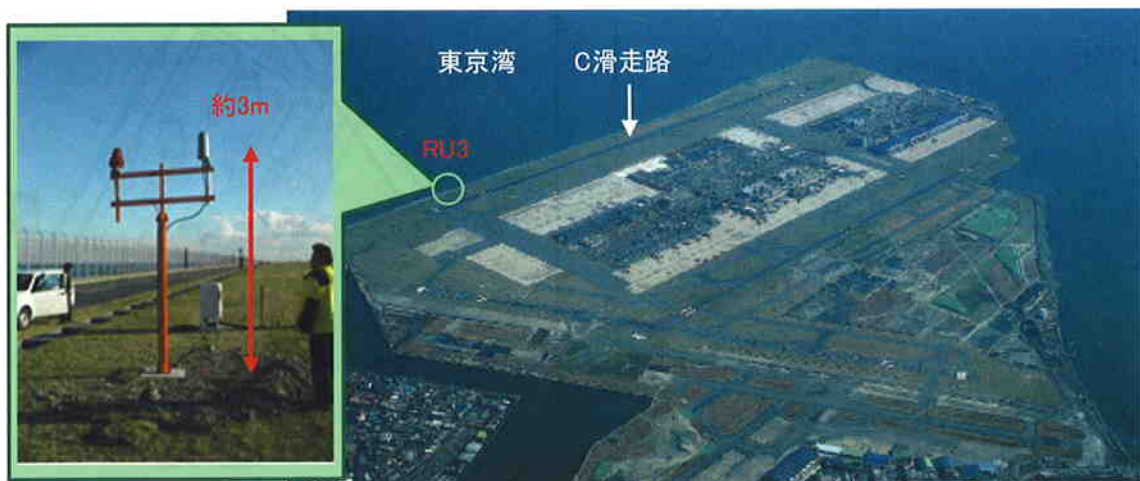
図4 RU3アンテナの設置状況
