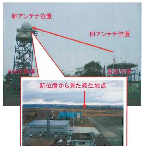
図9 RU5アンテナの移設状況
