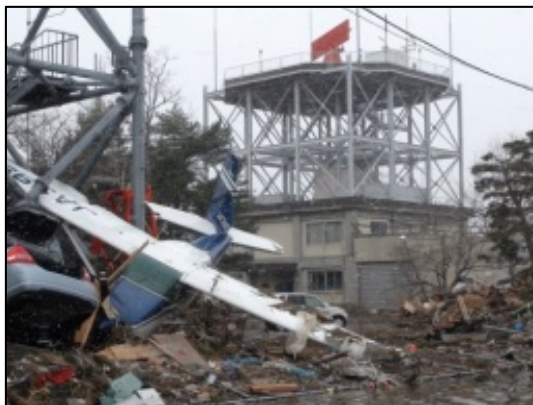
(a) 被災後の岩沼分室庁舎
