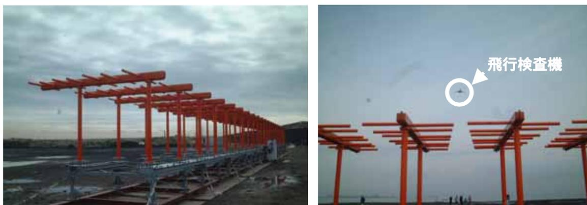
【 仮設置されたローカライザー・アンテナ（写真左）と実験中の飛行検査機（写真右） 】
