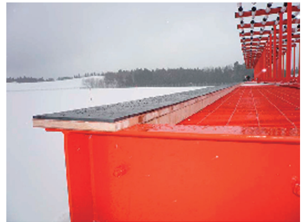
(b) LPDA下のキャットウオークの先端にフェライト板を敷設
