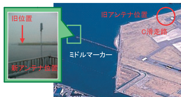
図3 移設後のRU3アンテナの設置状況
