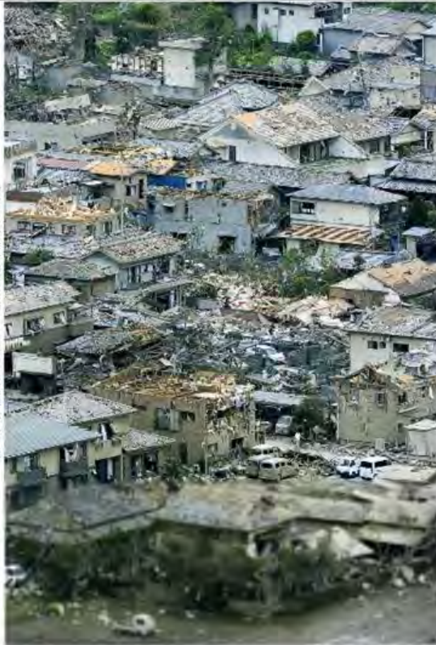
茨城県つくば市で発生した竜巻の被害状況。写真は5月6日の撮影。
