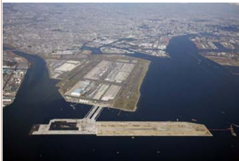
羽田空港D滑走路新設
