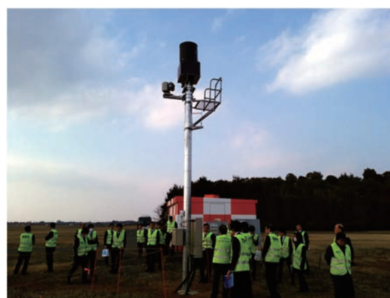
図 5 アンテナ局路面装置 A の概観
