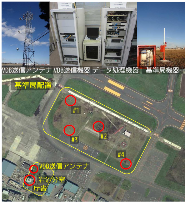
図3: 仙台空港 実験用 GBAS 地上装置
