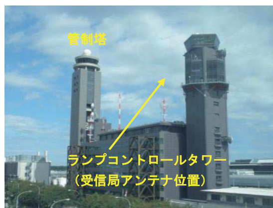
図 7 管制塔およびランプコントロール外観
