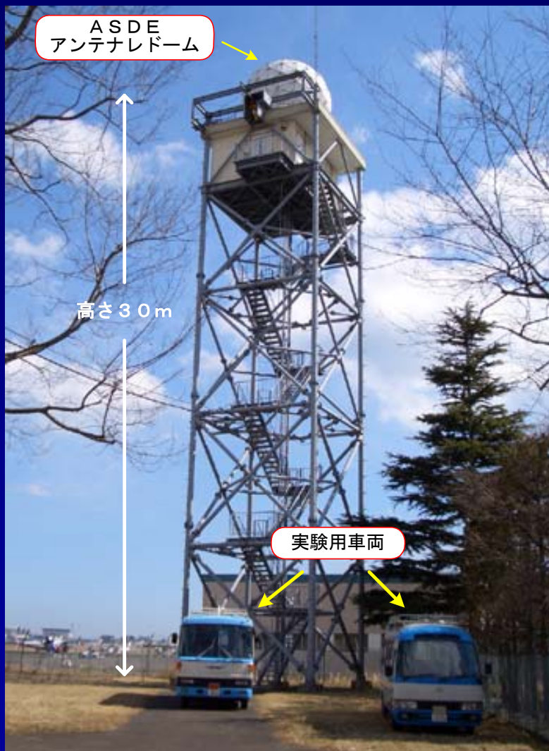
◆ASDEアンテナ鉄塔
