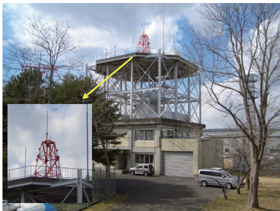
図7 ADS-B 受信局アンテナ設置外観
