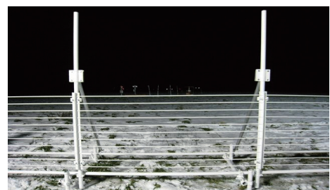
(b) 隠蔽フェンス工事写真
