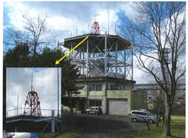
図8 ADS-B受信局アンテナ設置外観
