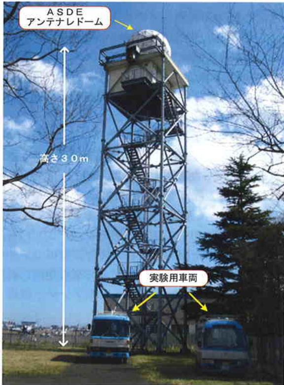
図7 ASDEアンテナ鉄塔と実験用車両の外観
