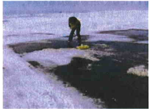
図7 現用反射板の除雪作業
