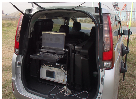
図 7 羽田空港仮設 GBAS 動作確認の様子
