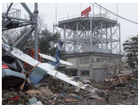
被災後の岩沼分室庁舎
