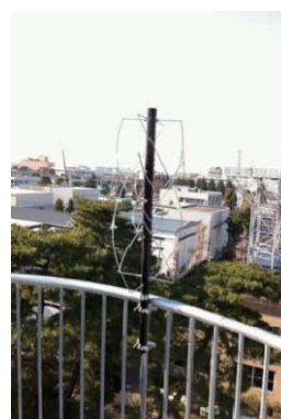
図2. 電子航法研究所 6 号棟鉄塔上に設置されている低軌道衛星ビーコン受信用 2 周波アンテナ
