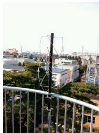
図 1. 電子航法研究所 6 号棟鉄塔上に設置した低軌道衛星ビーコン受信用 2 周波アンテナ
