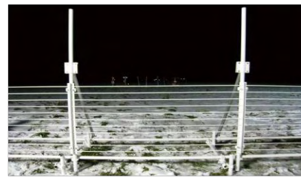
(b) 隠蔽フェンス工事写真
