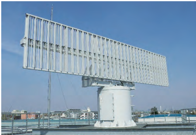
SSRモードS局の空中線 (SSR mode S antenna)
